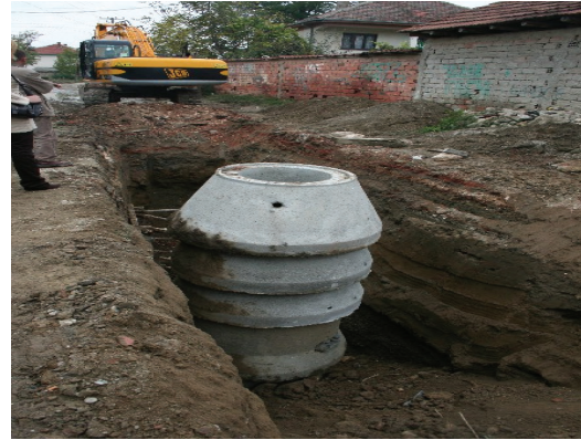
Fig.3.18 Realizimi i shahtit kontrollues – kaskad prej elementeve montuese
