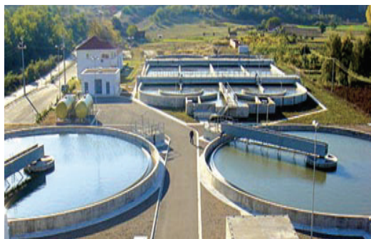
Fig.2.25 Pamja e një pjese nga objektet në stacionin për pastrim
