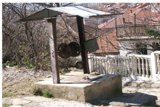
Fig.2.18 Pjesa mbitokësore e bunarit të gërmuar në anën e Prilepit.
