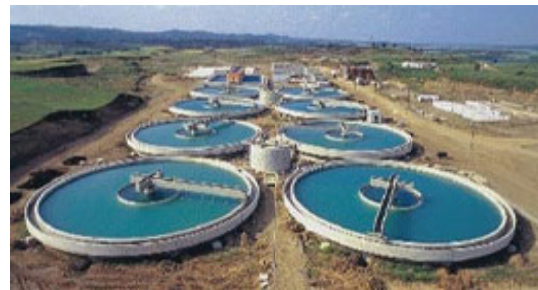
Fig.2.28 Sedimentues vertikal në fabrikën për ujë
