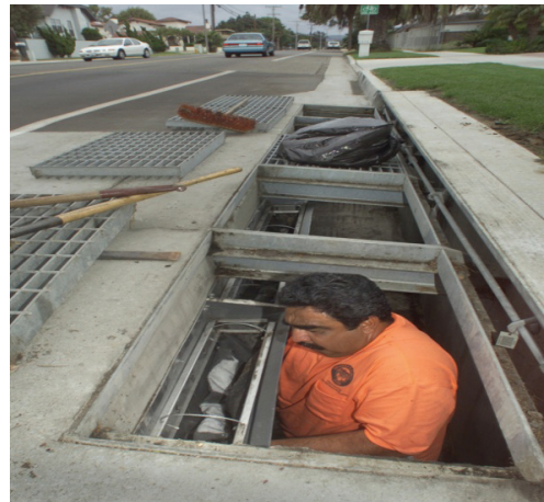
Fig.3.27 Mbledhësi rrugorë, mirëmbajtja
