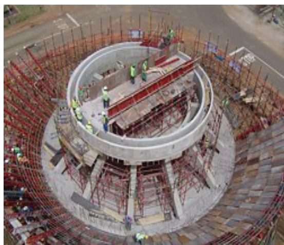
Fig.2.29 Sedimentuesi vertikal në bazë, prerje dhe ndërtim të së njëjtës
