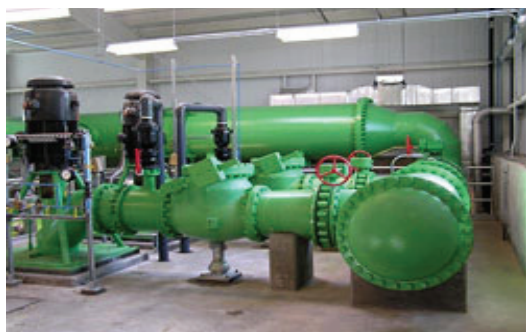
Fig.2.34 Pompat në stacionin e pompave
