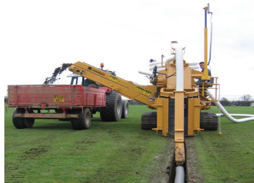
Fig.2.55 Montimi i PE gypave të vegjël
