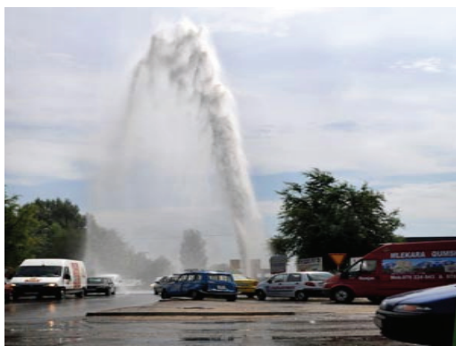
Fig.2.48 Uji i vakët rrjedh nga gypi i ujësjellësit të plasarit.
