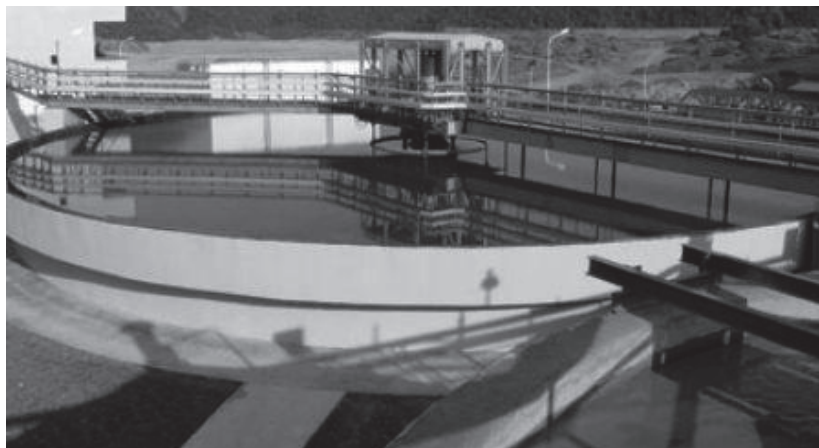
Fig. 2.20 Prerja dhe pamja e precipitatorit
