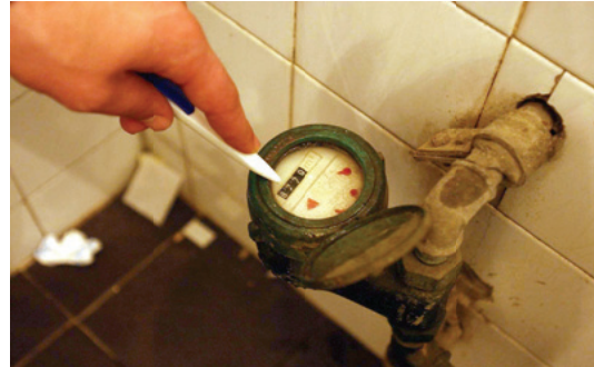
Fig.4.4 Matësi i ujit kontrollues
