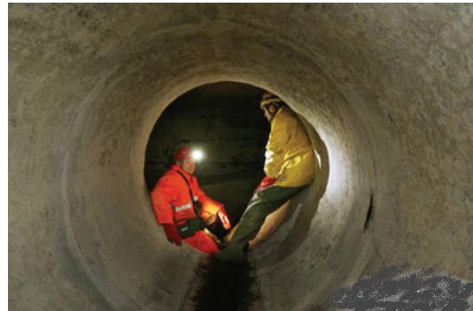
Fig.3.30 Pastrues të gypave të kanalizimit
