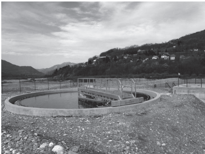
Fig.2.19 Prerja dhe pamja e sedimentuesit radial
