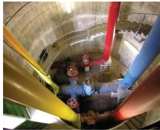
Fig.2.47 Komora e thatë, gypat, armaturat dhe shkallët
