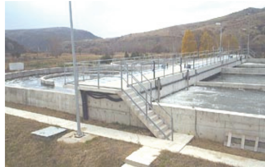
Fig.2.31 filtrues të shpejtë
