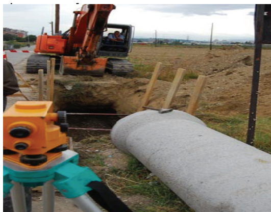
Fig.3.13 Gërmimi i istikamit dhe vendosja e gypit prej betonit me ndihmën e instrumentit gjeodezik
