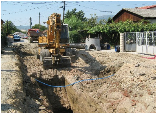
Fig.3.10 Gërmimi i istikamit për rrjetin e përgjithshëm
