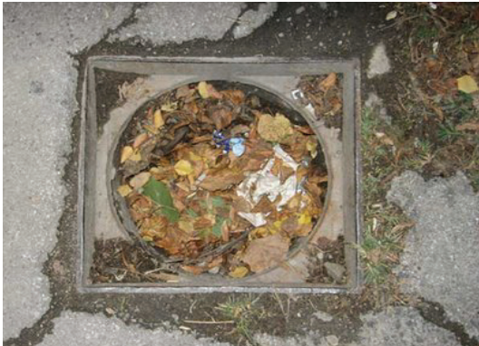
Fig.3.28 mbledhësi rrugorë pa grilla i bllokuar me gjethe dhe letër
